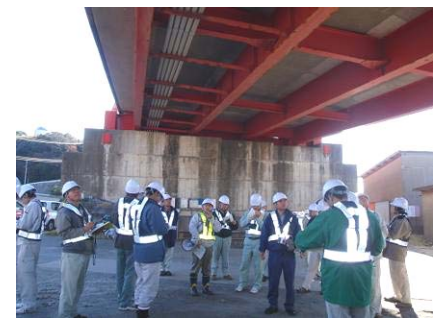
図5 現場実習講義状況
