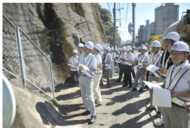
現地における点検状況
