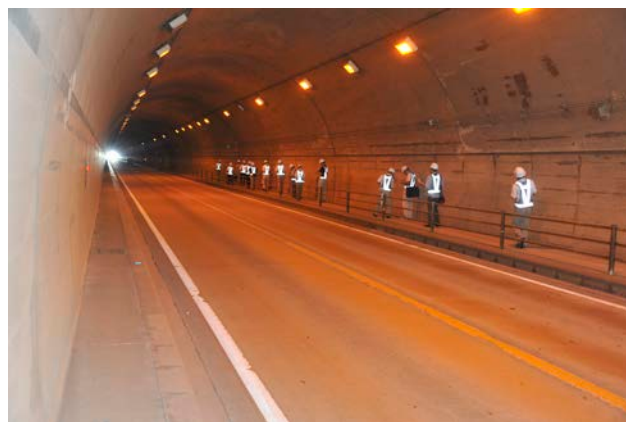
トンネル点検(小江小浦トンネルにて)
