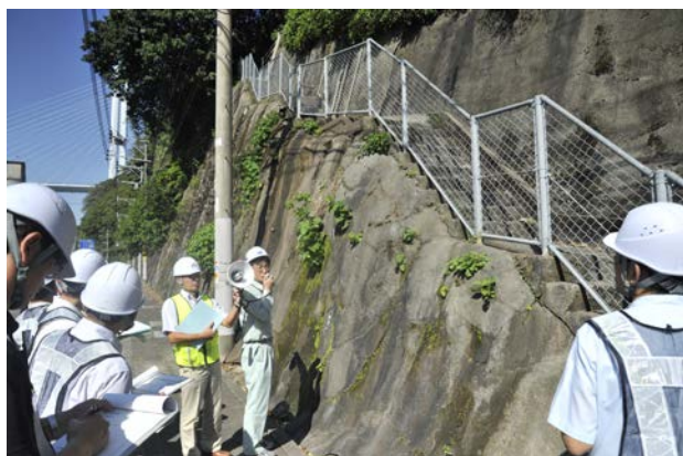
斜面の点検(魚見山にて)
